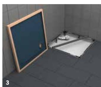
Umiestnite a vyrovnejte inštalačný rám. Nastavte požadovanú výšku najprv pomocou rohových a potom stredových nožičiek, aby stáli pevne na podlahe a slúžili ako opora. Umiestnite sprchovaciu vaničku na rám.
