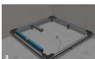
Pomocou vodováhy a pomôcok pre obkladanie nastavte výšku rámu. Aby ste predišli posunu, pripojte rám pomocou podlahových úchytek.
